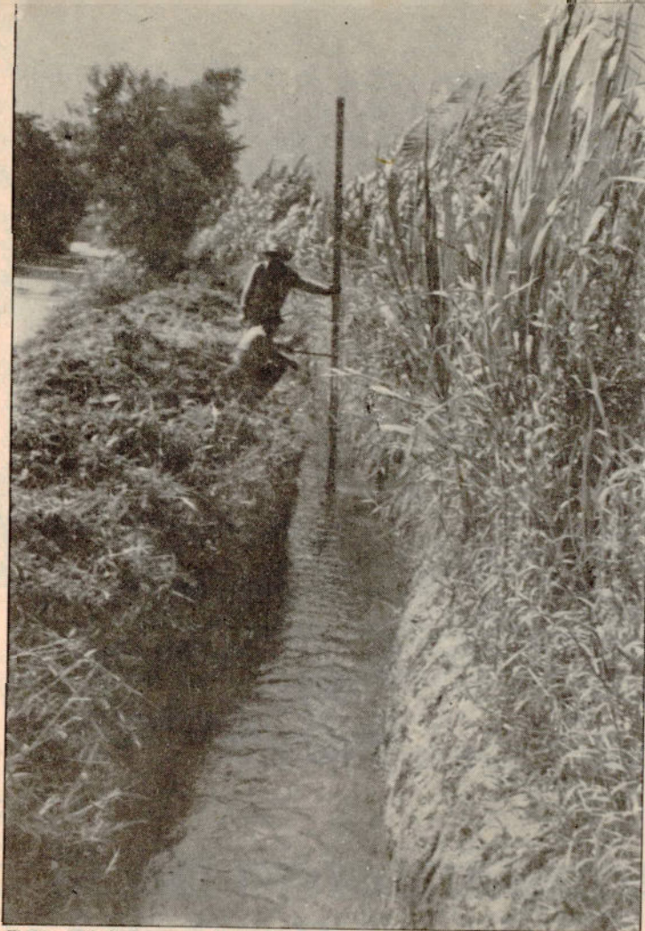
Reconocimiento y medición del caudal para irrigación.
